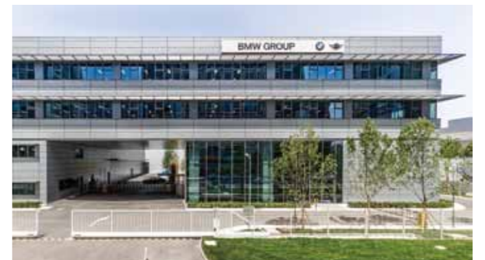
北京环普国际科技园一期 宝马集团中国研发中心
